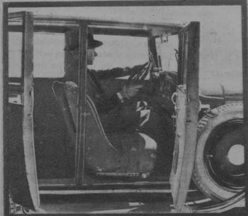
■ El volante (de tres radios), las palancas y los instrumentos del tablero están dispuestos del modo más cómodo para el conductor. Los dos asientos delanteros, independientes y corredizos, permiten adaptarlos a la estatura del ocupante
