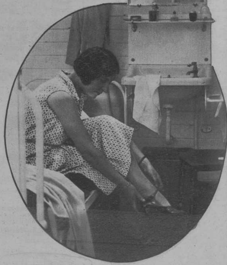
Una señorita, sentada en la cama, abrochándose, con alguna dificultad, un zapato. No se trata de una celda de reformatorio, ni de un cuartito de hospital. Es, sencillamente, un dormitorio de hotel flotante
