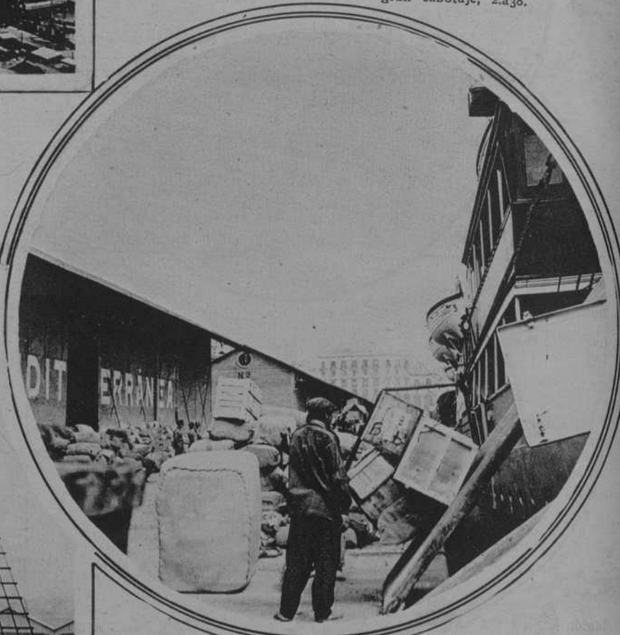
Detalle de la descarga de un buque
