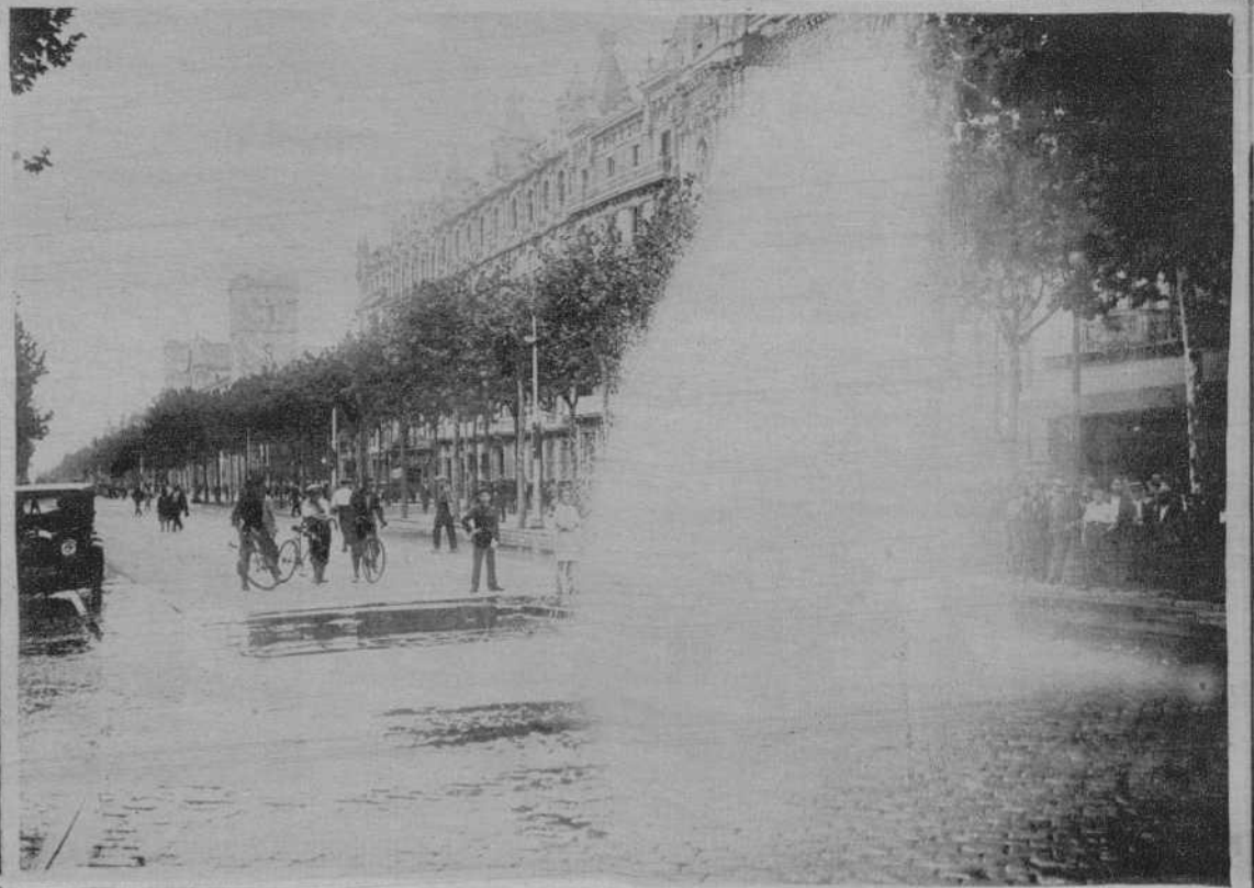
BARCELONA.—La rotura de una tubería de conducción de agua, en la Ronda de la Universidad, dió lugar a un surtidor.—(Fot. Maymó)
