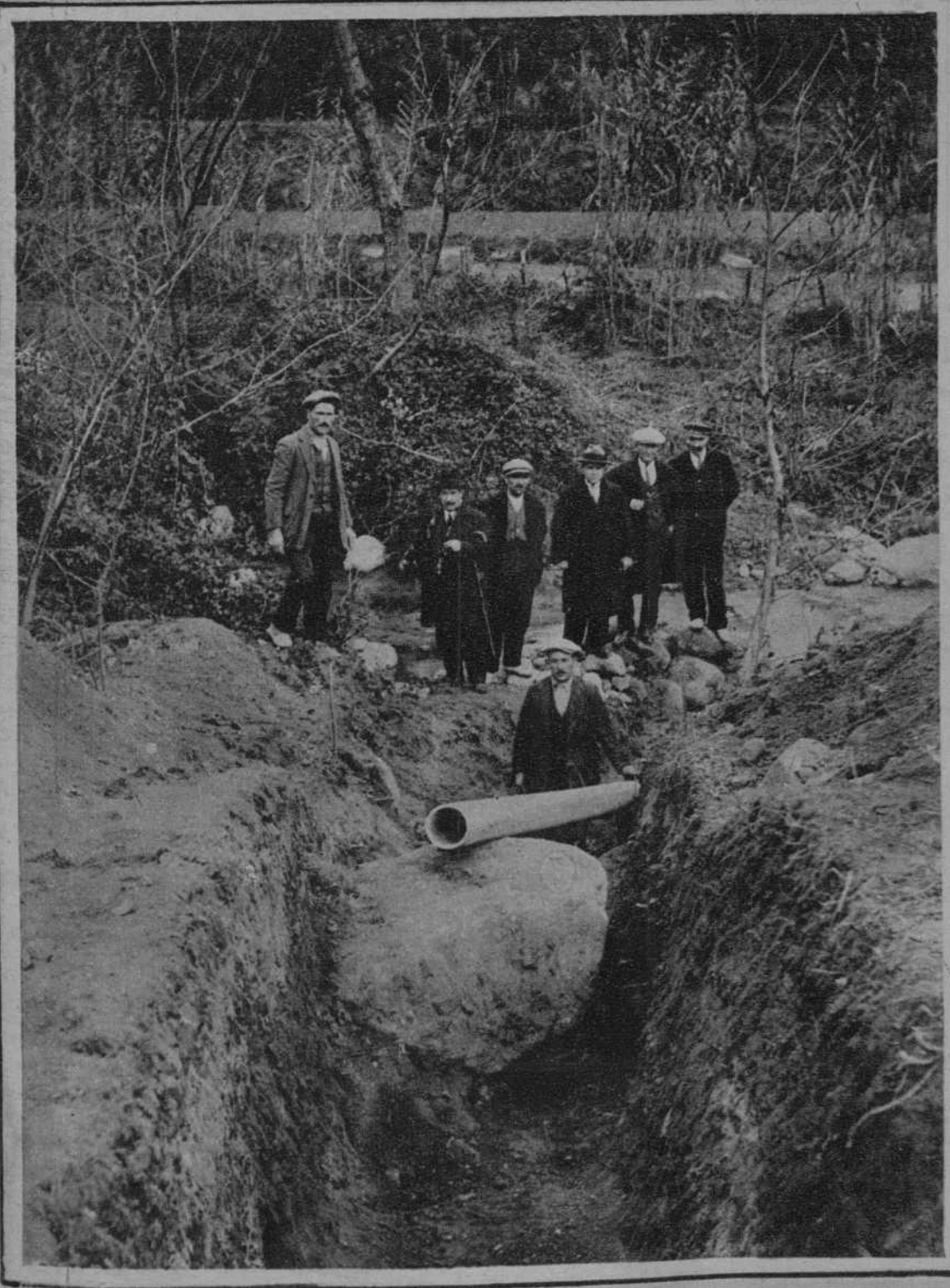
La nueva conducción de aguas a Santa Coloma de Farnés.—(Fot. Freixas)
