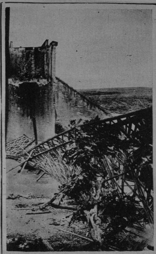
Hundimiento de un puente de hierro en la línea de Córdoba a Málaga, después de pasar un tren correo. (Fot. Santos)
