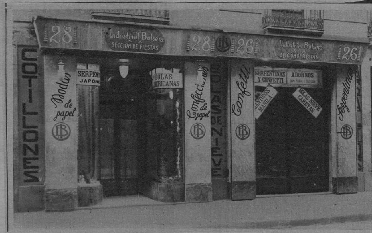
Fachada de la casa de la calle Union 26 y 28 donde tiene instalada "INDUSTRIAL BOLSESA S.A." su Exposición de artículos para fiestas.
