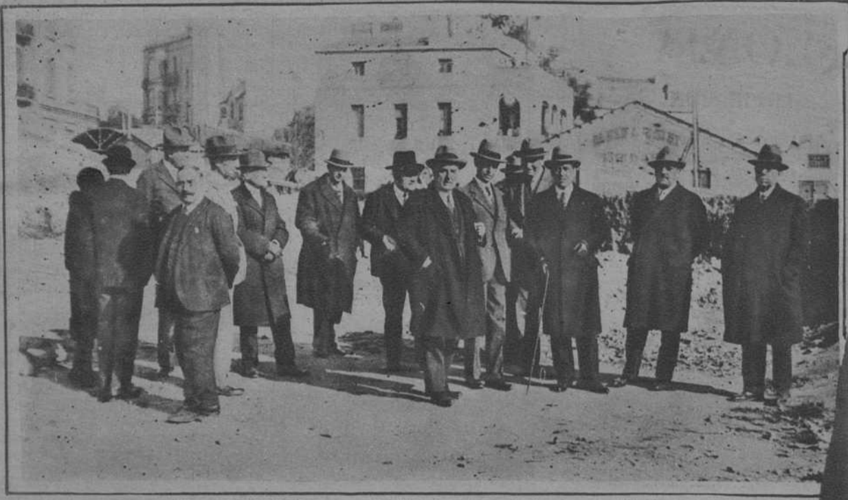
El alcalde Sr Baron de Viver y el teniente de alcalde Sr Llansó visitando las obras de prolongación de la calle Balmes Foto Merletti
