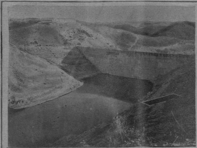
Estado de la presa en octubre de 1927.—La presa tiene una altura de 33 metros y un ancho de 122 metros. Podrá contener 3.000.000 de metros cúbicos de agua para abastecimiento de Huelva y sus alrededores.
