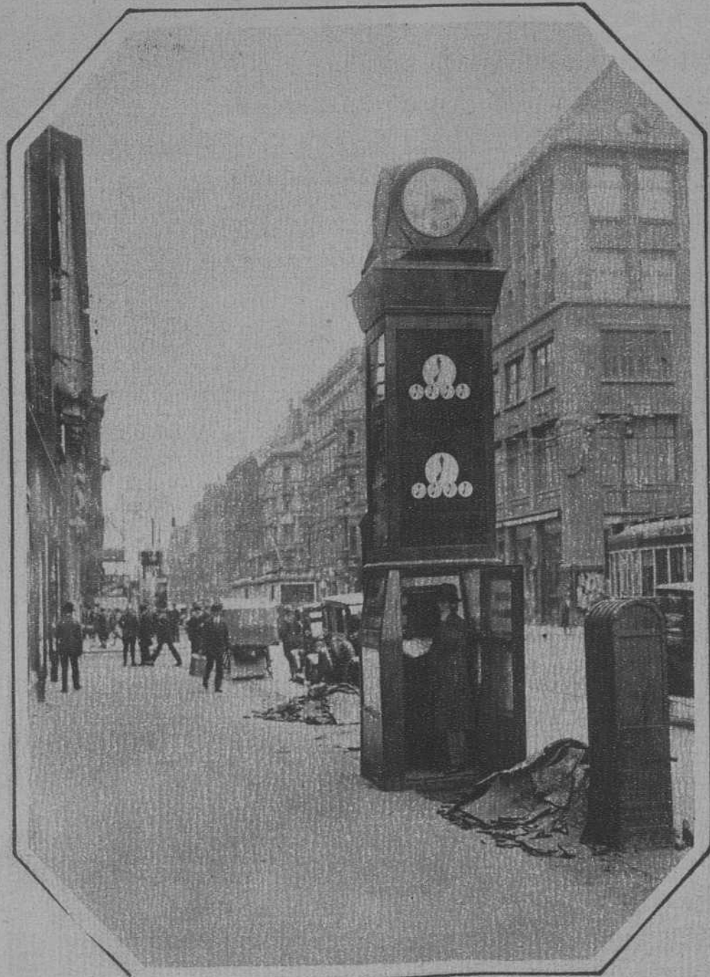
LEIPZIG.—Torres de reloj instaladas en las calles de Leipzig, con cabina telefónica en la base para uso del público. (Fot. Sherl).
