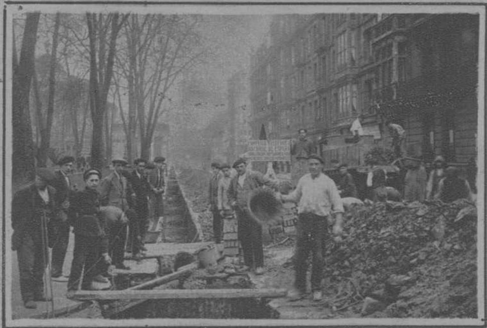
BILBAO.—CANALIZACIÓN SUBTERRANEA PARA TENDER LOS CABLES DE LA RED UR- BANA NUEVA, QUE SE CONVERTIRÁ EN AU- TOMÁTICA. (FOTOGRAFIA OBTENIDA EN LA CALLE DE COLÓN, ESQUINA A MAZARREDO)
