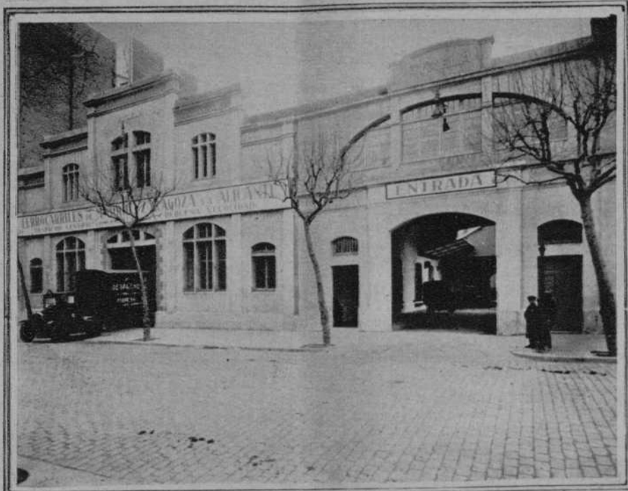
VISTA EXTERIOR DEL EDIFICIO
