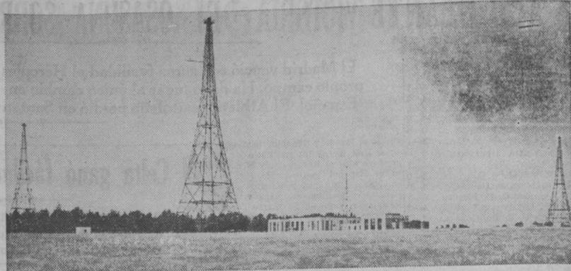
Bello conjunto de antenas instaladas por la Compañía Marconi en el importante Centro de Radiodifusión de Brookmans Park. Las cuatro esbeltas torres que muestra la fotografía corresponden a dos modernos transmisores de 50 kw. cada uno
