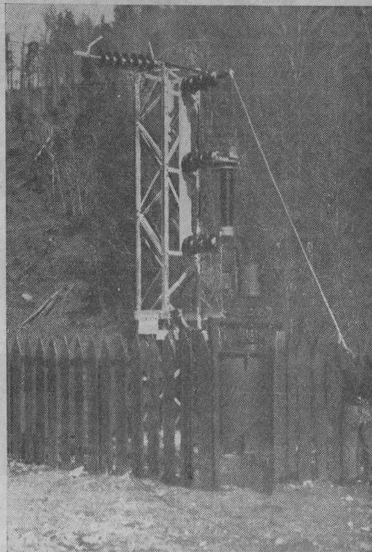
Subestación rural de transformación y distribución, 50 KVA., 66.000/2.300 volts., monofásica
