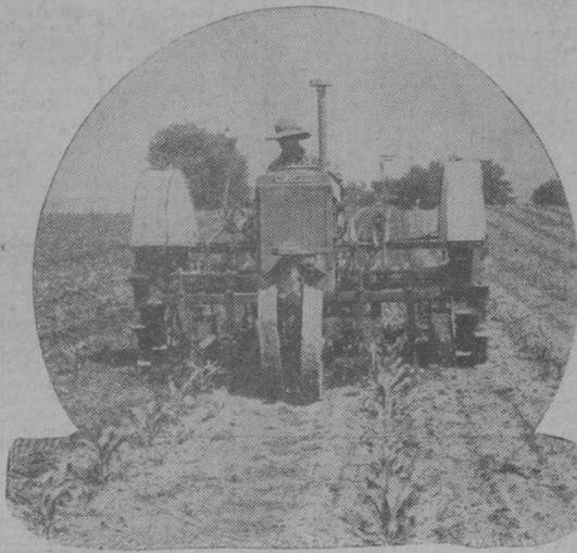
El tractor, no conforme con su aplicación a la labor corriente, ofrece hoy tipos especiales ligeros, de ruedas, con espaciamiento variable, para ejecutar los trabajos de cultivo en siembras alineadas con aparatos que se maniobran utilizando la misma fuerza del motor
