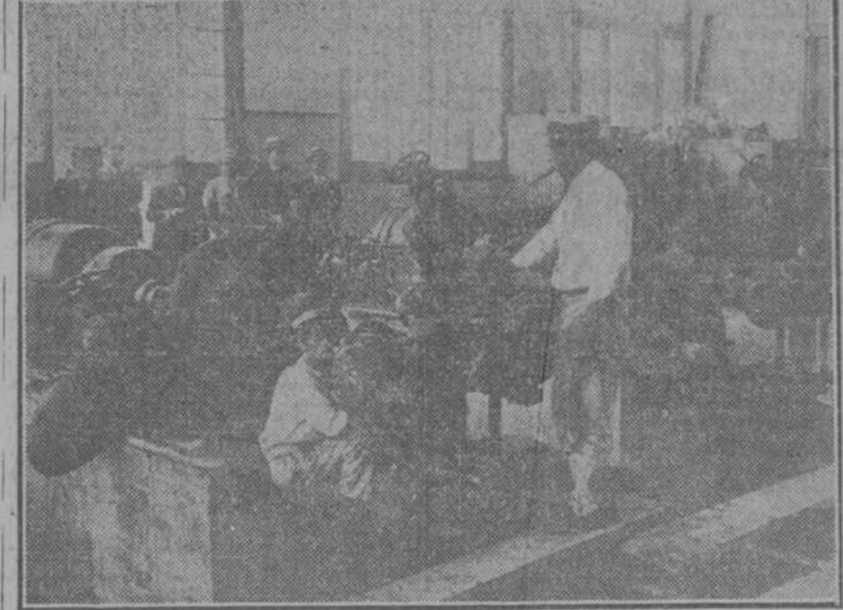
LAS NUEVAS BOMBAS, SISTEMA DE TURBINA, QUE SE HAN INSTALADO EN PALATINO
