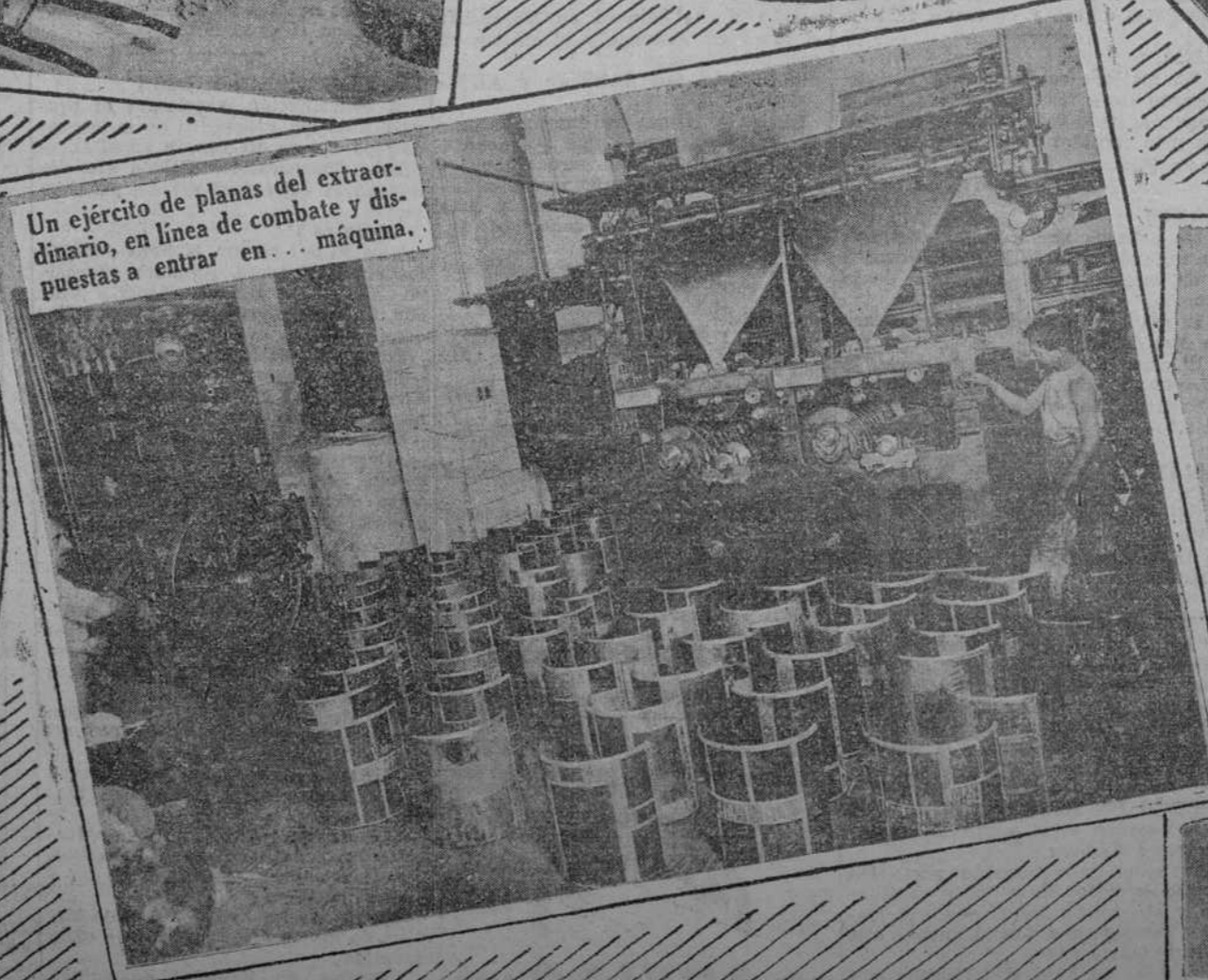
QUINCE MIL libras de plomo se invierten en la estereotipia de las planas del extraordinario.
