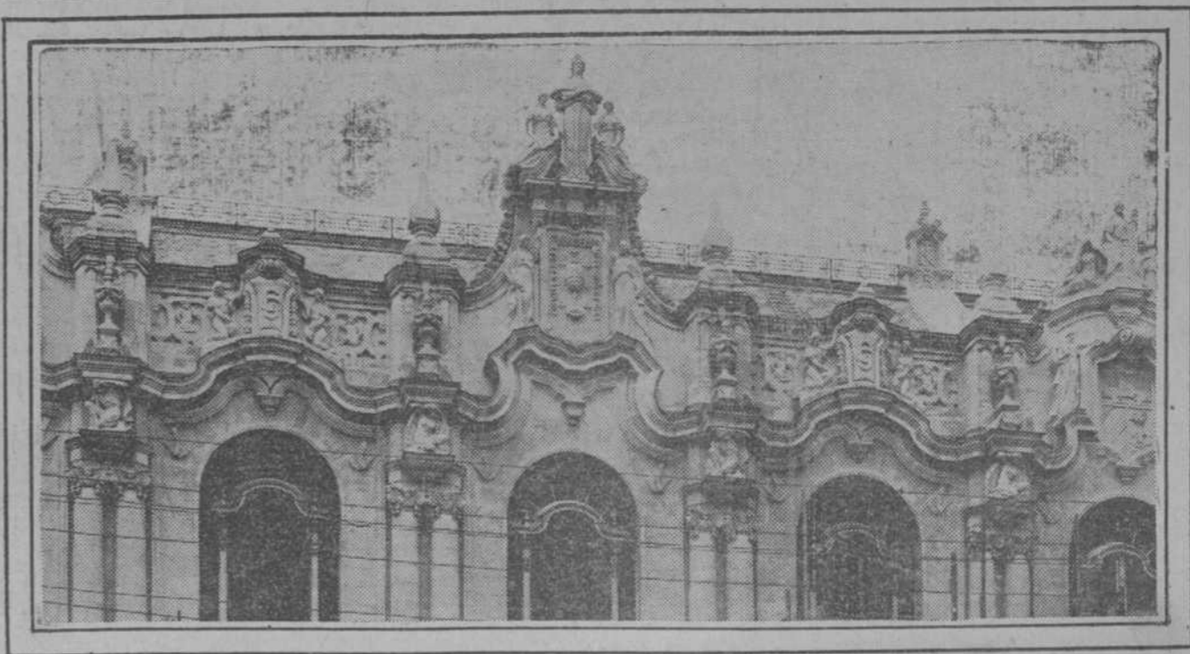
Un detalle de la cornisa de la fachada principal
