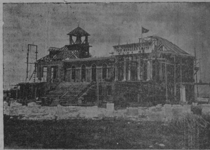
Palacio en construcción para el "Vedado Tennis Club"
