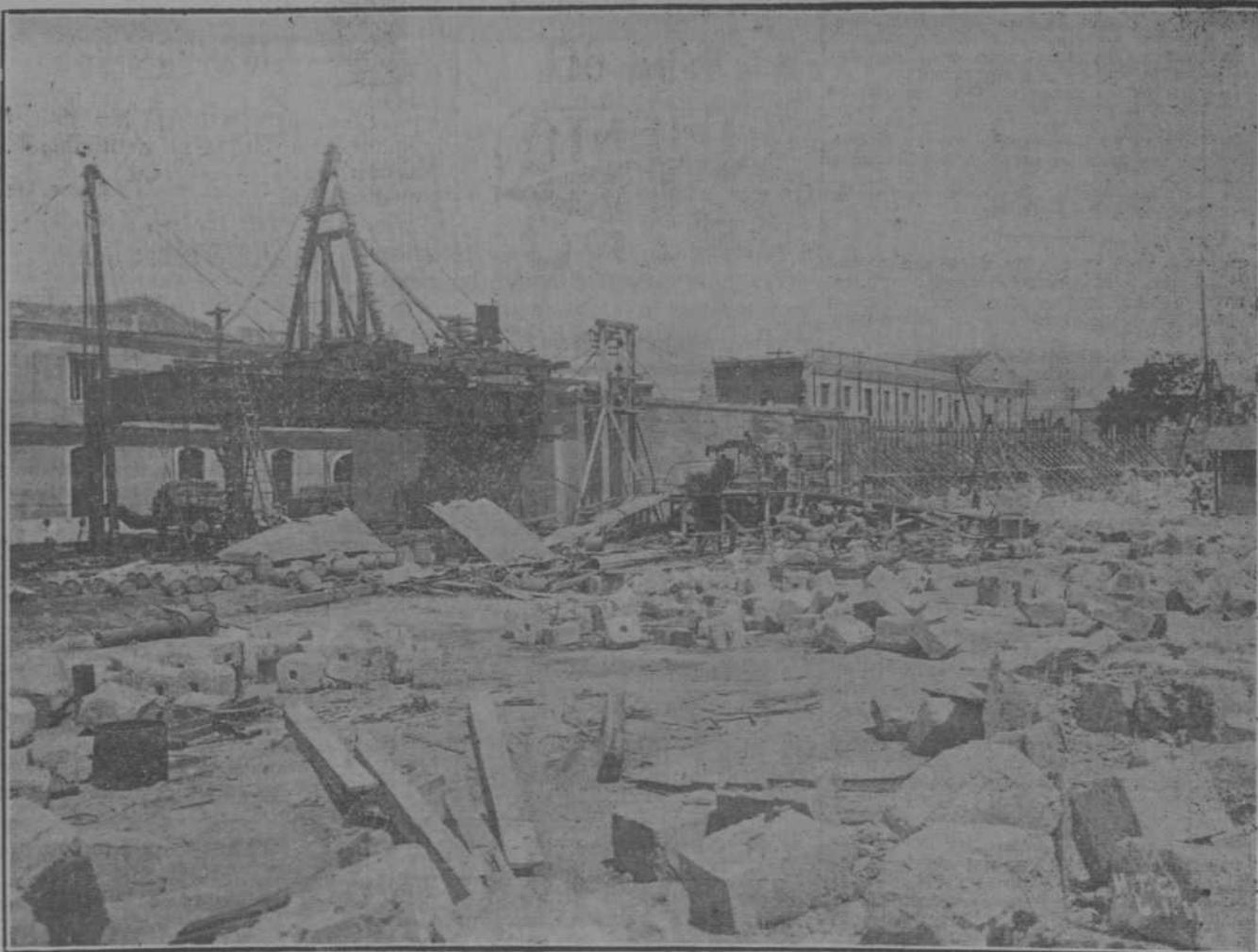
Vista de los trabajos que se están realizando para la construcción del elevado desde el Arsenal hasta Atarés.
