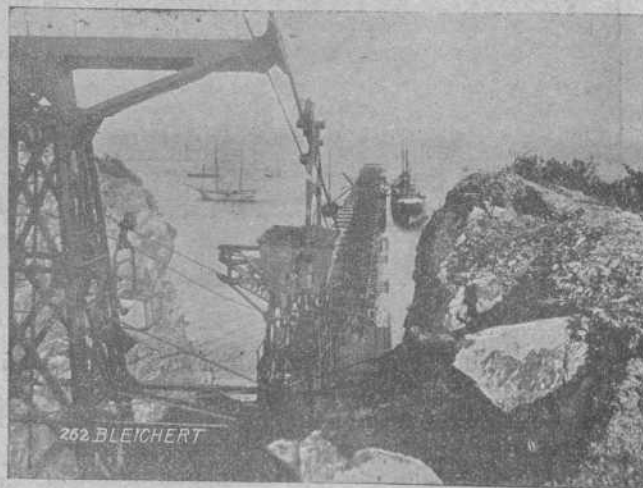
Vía aérea construída por Adolf Bleichert & Cía. en Giove Portello.
