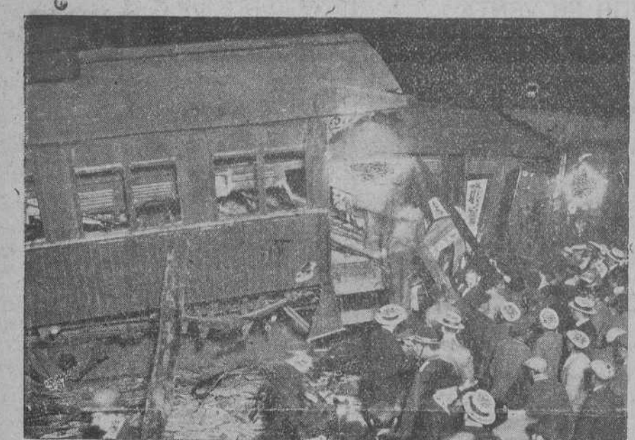
LA CATÁSTROFE FERROVIARIA DE VILLAVERDE.—Coches del correo de Toledo destruidos junto a la estación.—(Foto. Vidal.)
