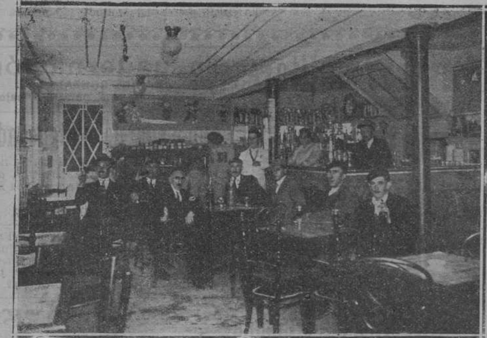
INTERIOR DEL MAGNÍFICO BAR MUNDIAL, DE DON ANGEL HIERRO, INSTALADO EN LA CALLE MAYOR, DE REINOSA. (Foto Samot)
