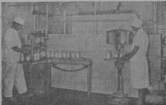
Embotellado y cierre automático de la leche cruda, filtrada y enfriada.
