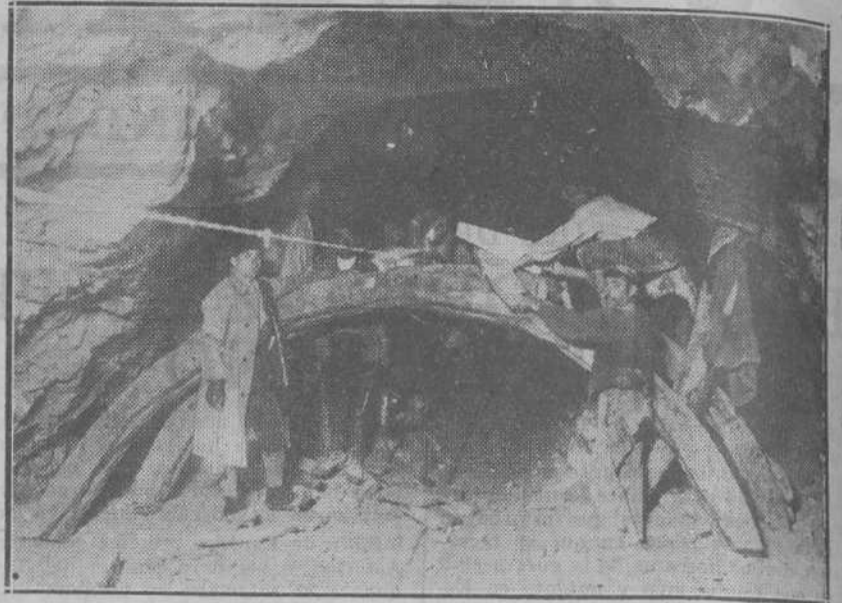
Los obreros, a cuarenta metros de profundidad, se afanan en su labor de perforar la montaña. (Fot. Alejandro.)
