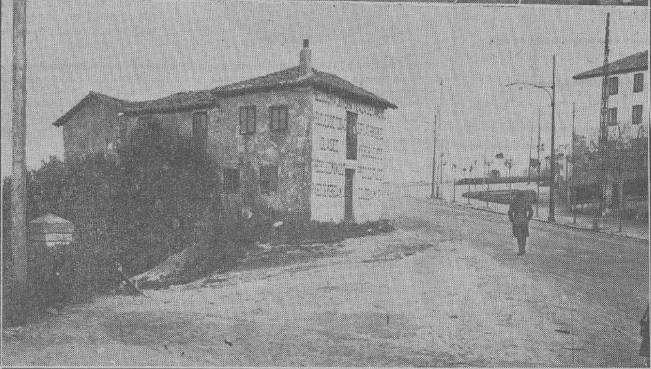
La desaparición de la casa llamada "de los Arbolitos", en el Sardinero, es una cosa inevitable. Y está bien. La desaparición de esta casa es ya por sí sola una mejora para aquel bello lugar. Unase a esto que permitirá realizar amplias y notables reformas en el paseo y tendremos que fué un acertado acuerdo del Ayuntamiento el de que la "Casa de los Arbolitos" pasara a la historia de las cosas inútiles locales. (Foto Alejandro.)
