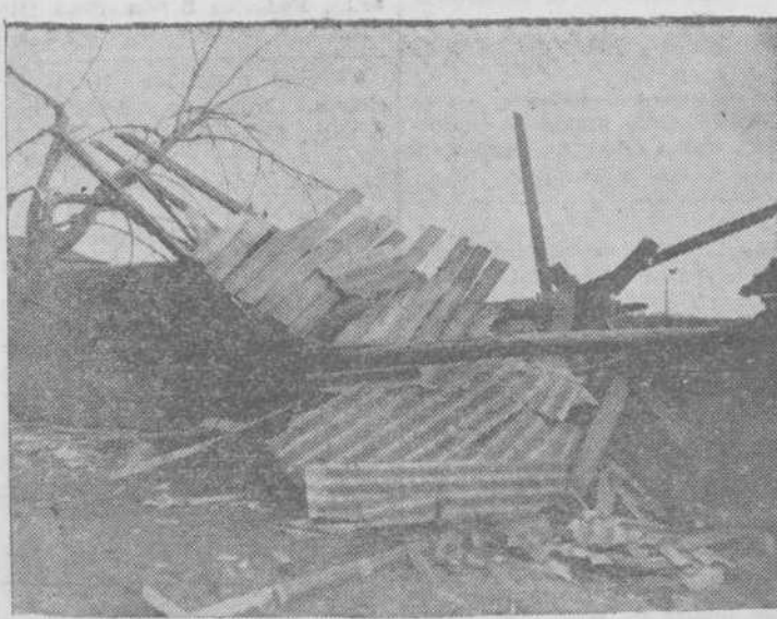
He aquí el tejado de una de las casas de la Avenida del Puente Nuevo, que desmantelado entero por la fuerza del vendaval, cruzó los aires sobre otras edificaciones, vendó a estrellarse contra las tapias del convento de Madres Jesuitas, en cuyas paredes abrió una brecha considerable.
