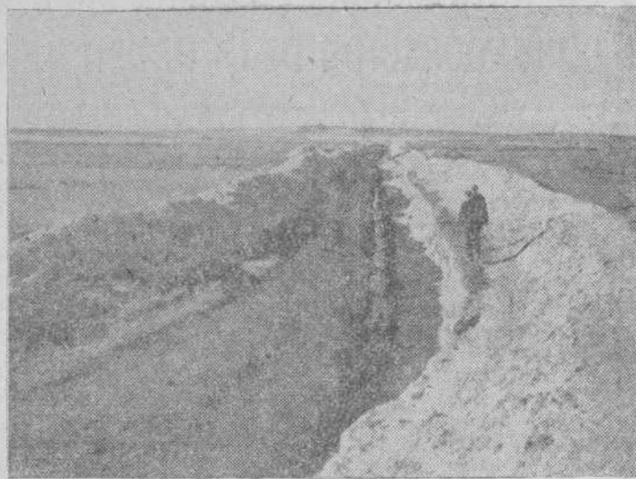
Un aspecto de la conducción de aguas abierta por los obreros de Villoria, de dos kilómetros de larga, para llevar las aguas de un abundante manantial hasta los huertos familiares.
