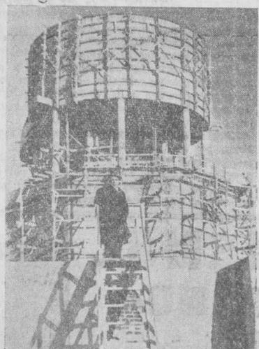
La torre del superdepósito se reviste de fábrica constituida por mampostería y sillería hidráulica, sobre la cual se apoya la cubierta de cerchas metálicas y teja árabe.
