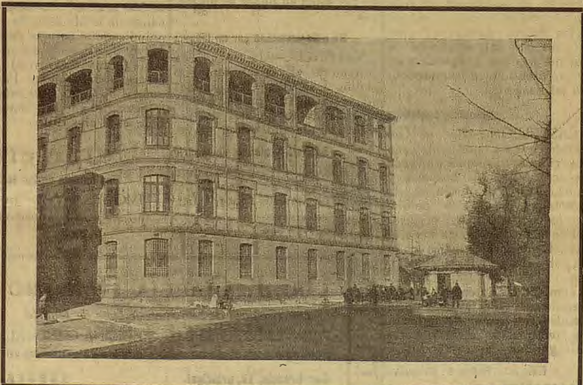
Convento y Colegio de Santa Rosa, con internado para señoritas FACHADA PRINCIPAL
