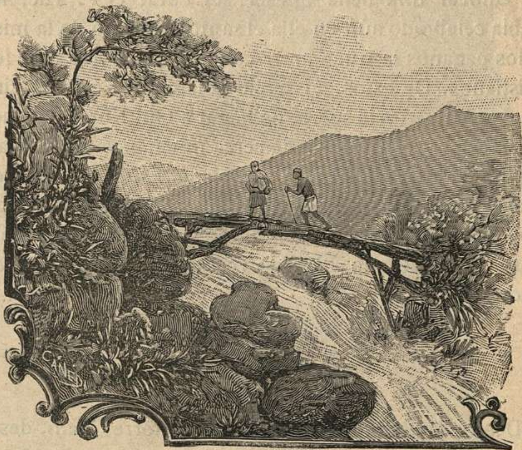
Este puente no tiene barandilla.
