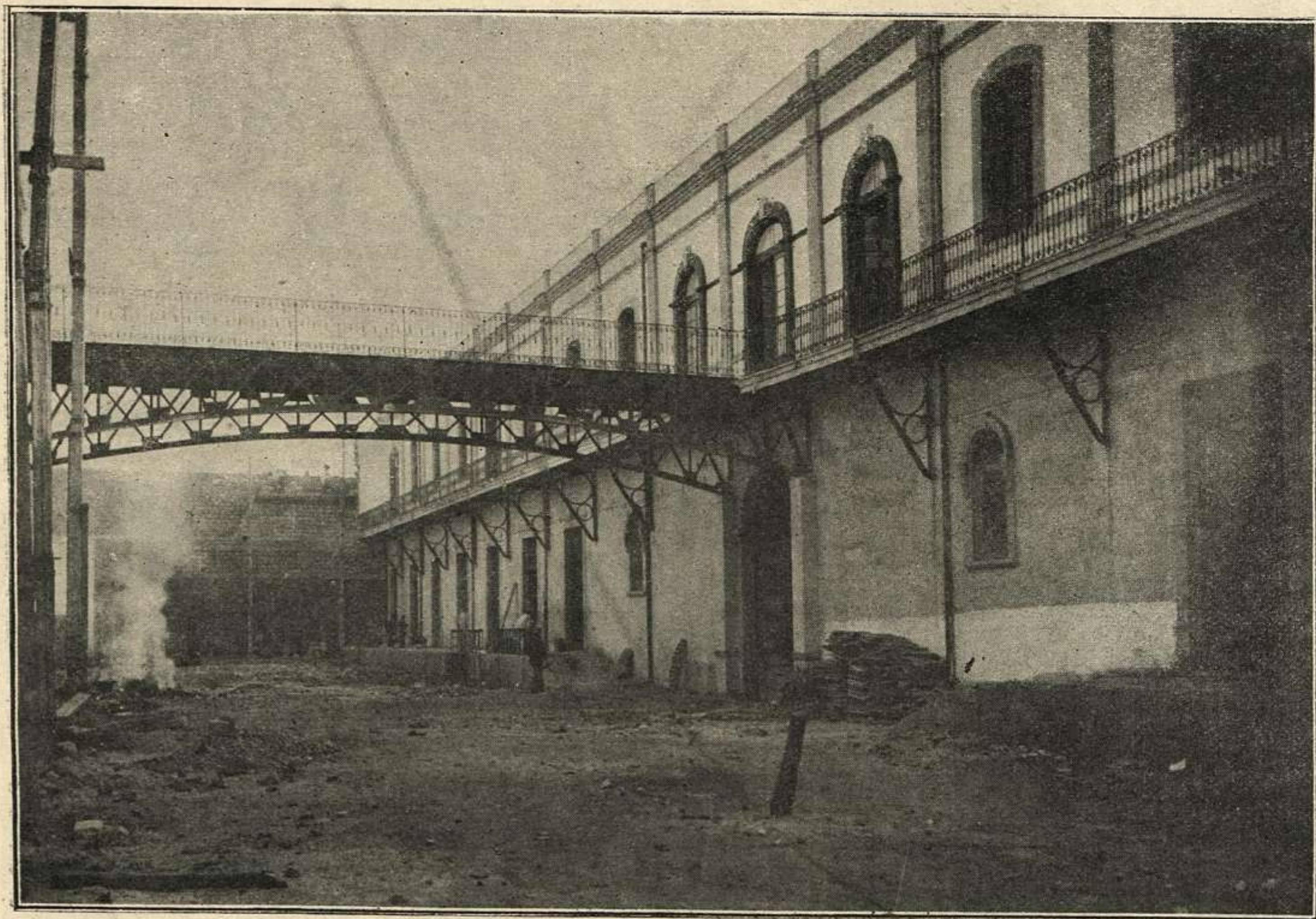
Puente sobre el patio principal.
