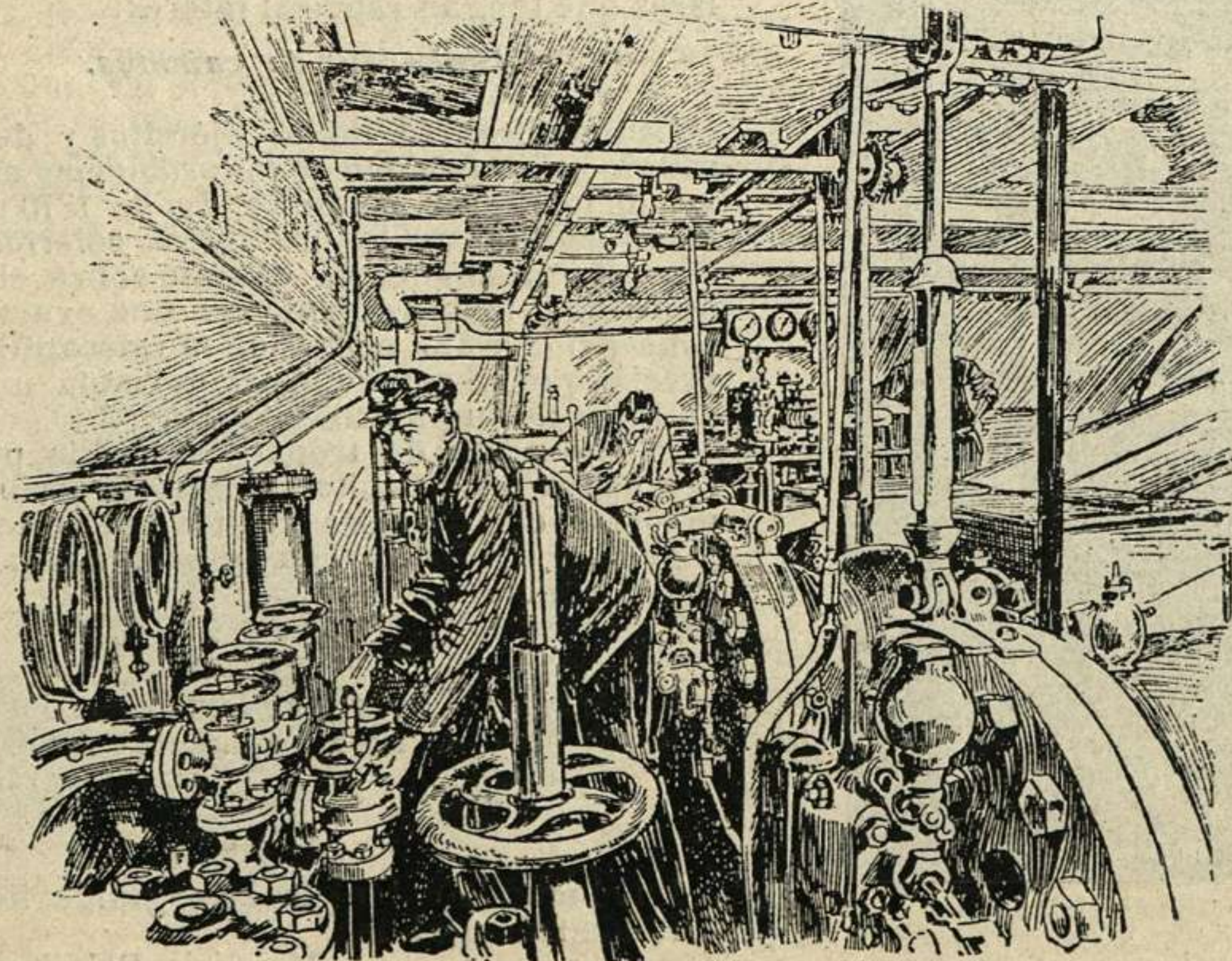
CÁMARA DE LAS MÁQUINAS
