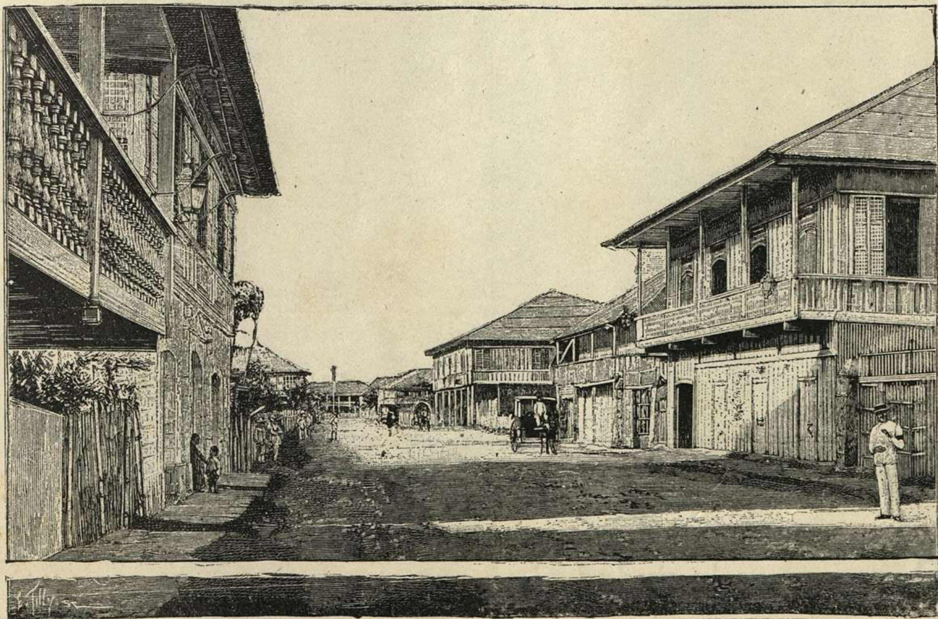
FILIPINAS—CALLE DEL ARSENAL EN CAVITE
