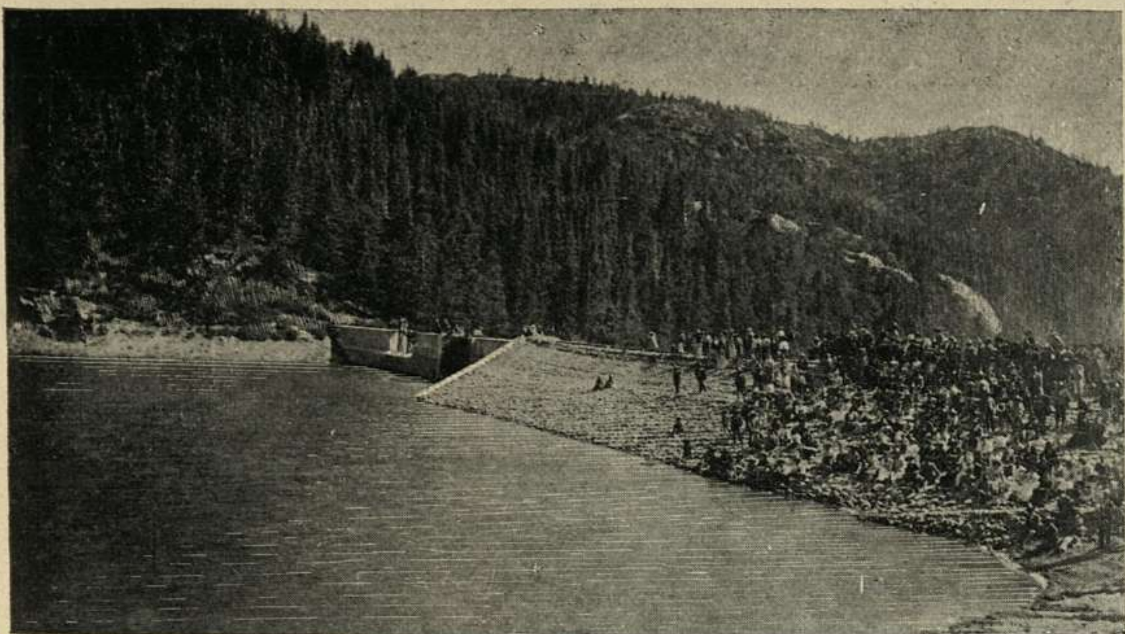
EN LA CORTINA DE LA PRESA
