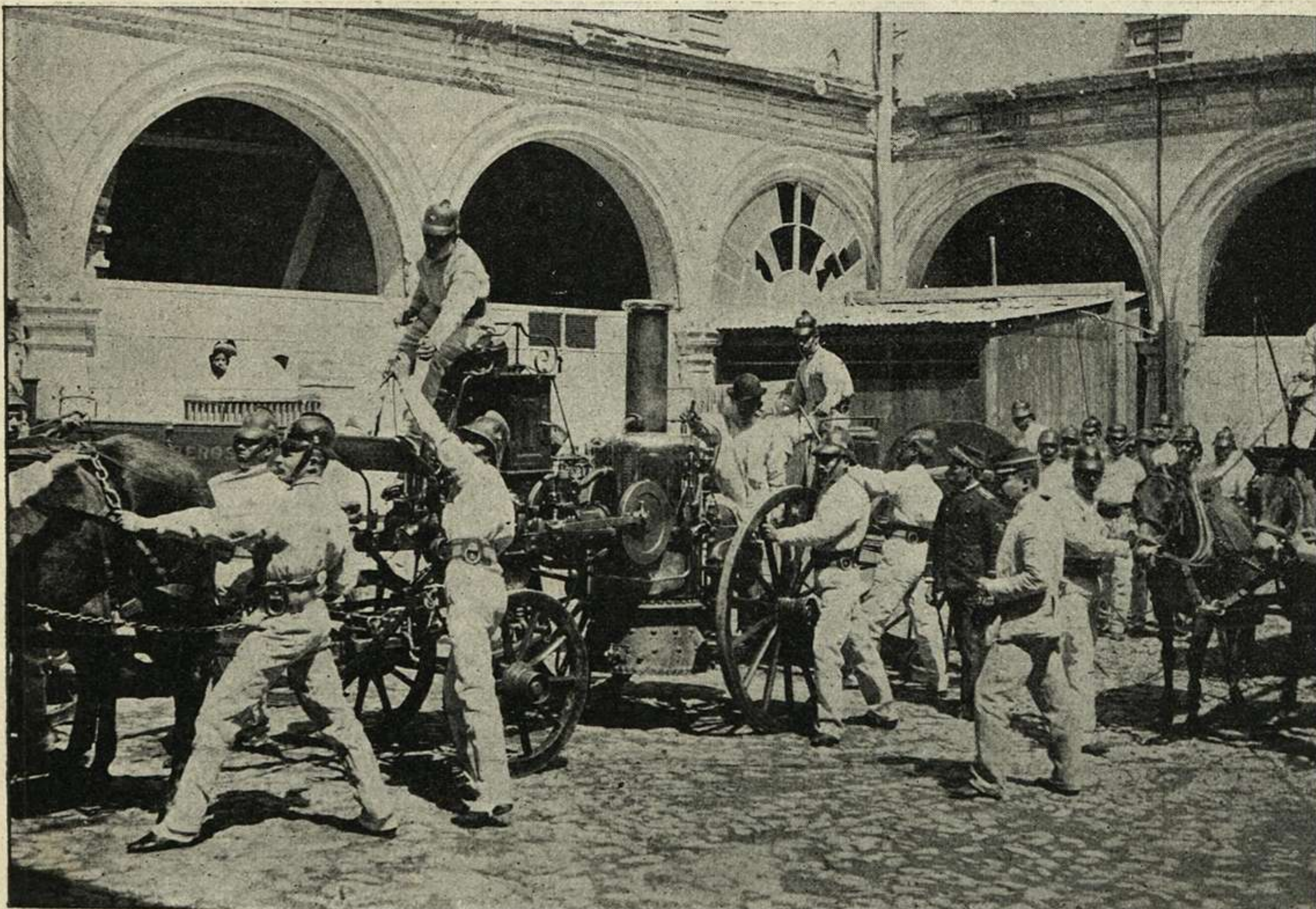
SALIDA DE LAS BOMBAS
