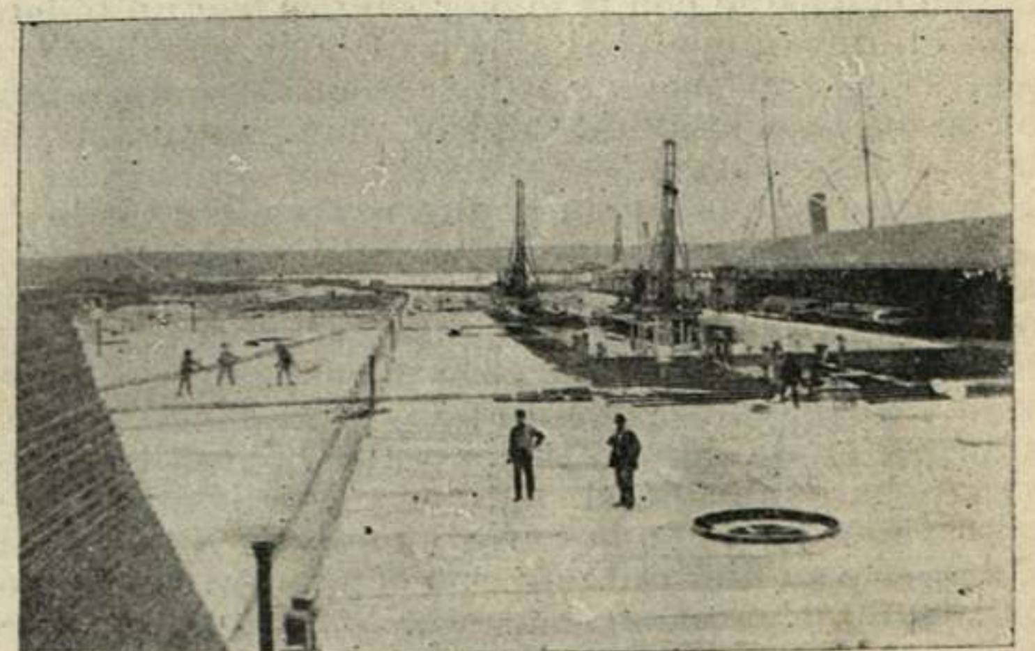
Vista oriental de las obras del muelle Fot. Ibañez.
