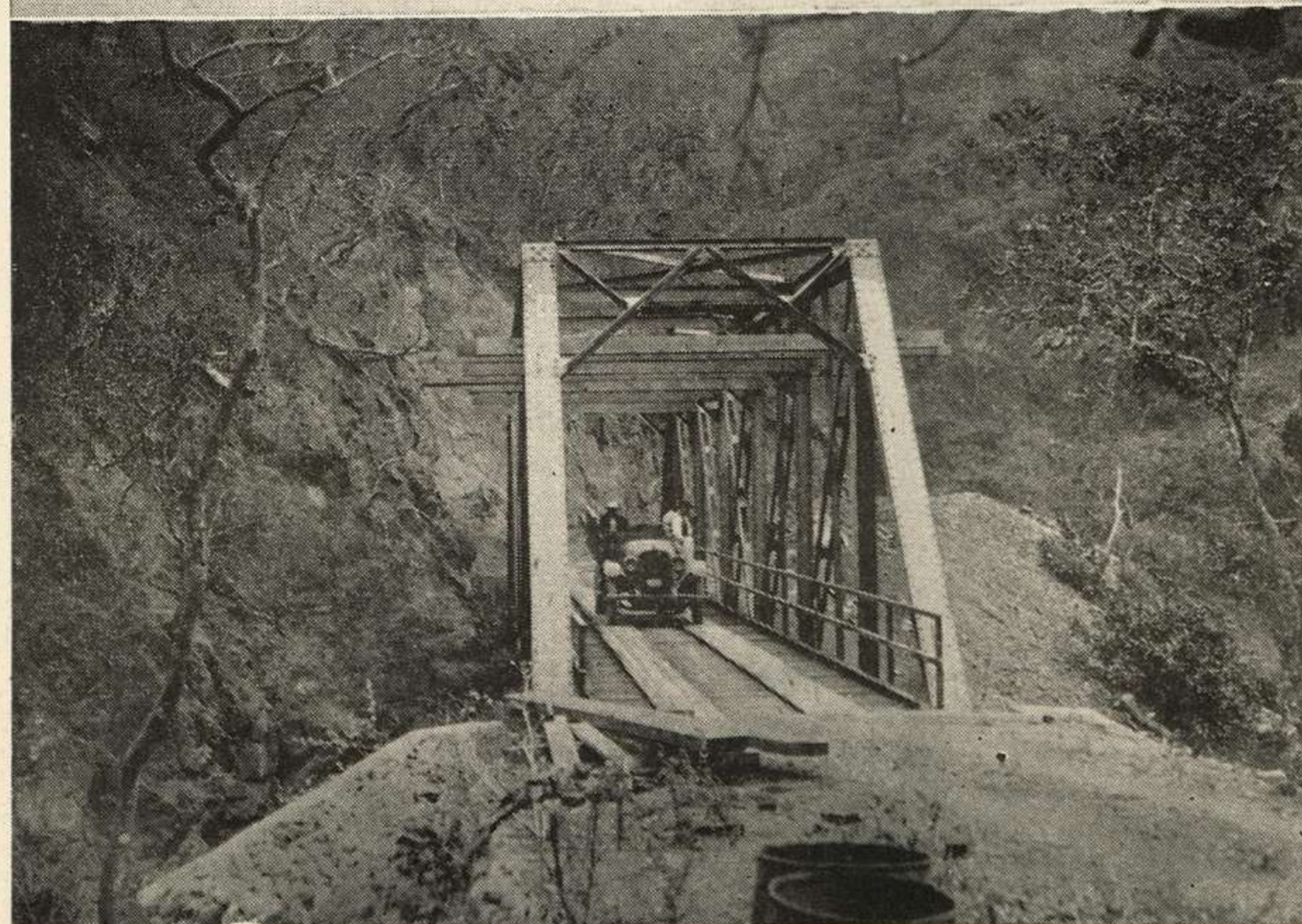
Dos tramos de la ruta Olmos-Bellavista. Abajo: el puente Silencio
