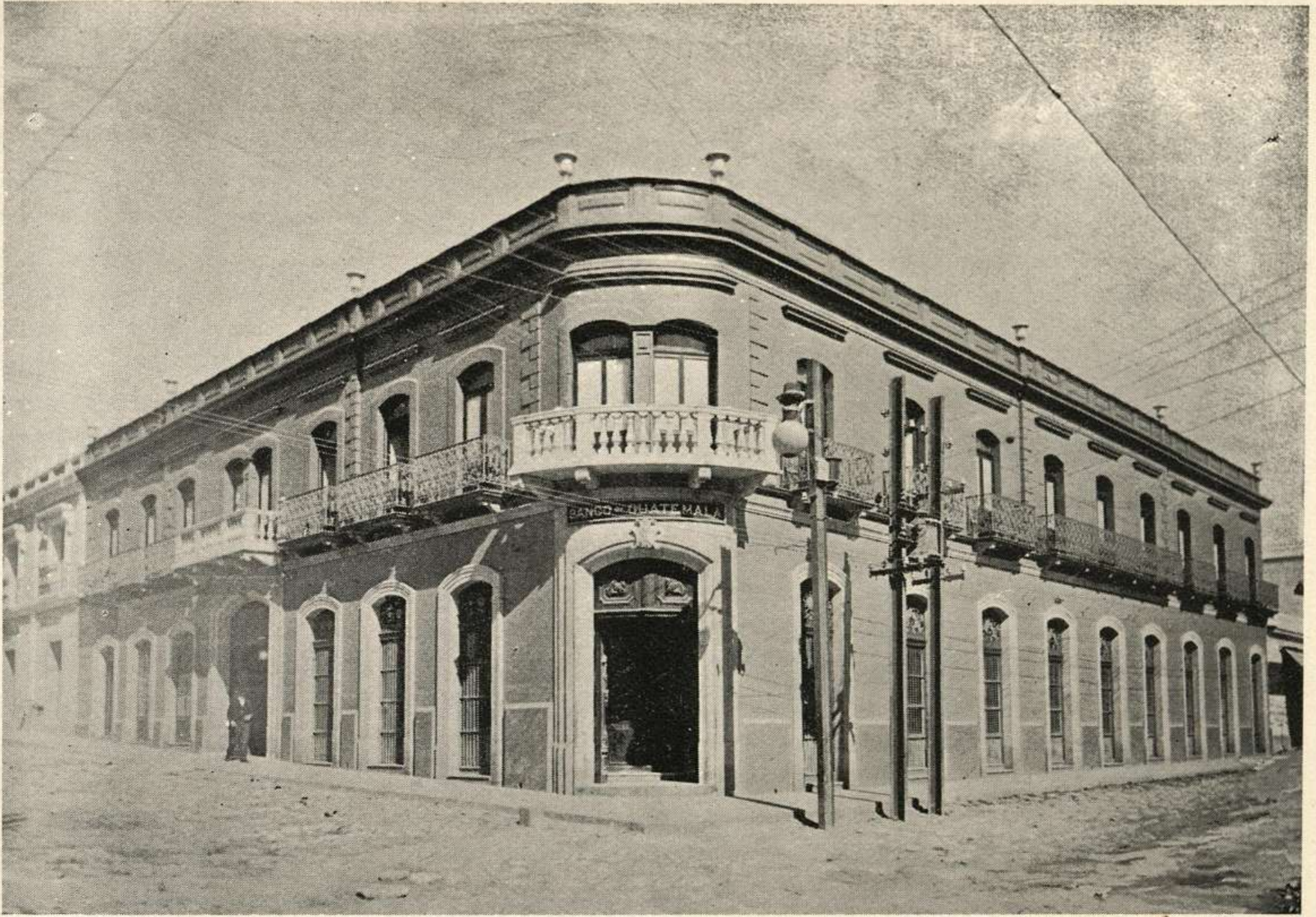
EDIFICIO DEL BANCO DE GUATEMALA.
