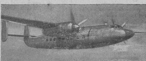
El más moderno avión de pasajeros, «Embrujador de la velocidad aérea», es de 40 plazas, con una constante velocidad cruceo de 450 kilómetros por hora. Tiene un radio de acción de 1.600 kilómetros con su carga normal de pasajeros y equipaje
