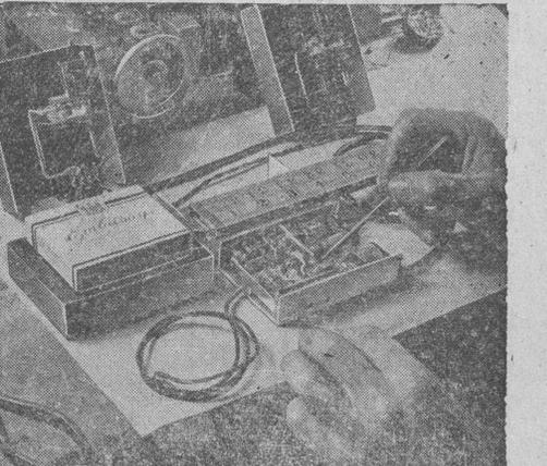
Fabricación del tele-radio, aparato transmisor receptor de bolsillo, con una radio de acción de 800 metros (Calpe).
