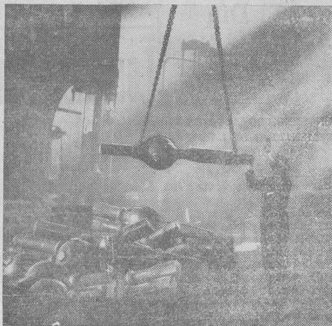
Las cubiertas del eje posterior de los vehículos pesados, son trasladadas, en los talleres de la Vickers, de un lugar a otro, según las necesidades requeridas por la industria, examinándose en cada sección sus condiciones y garantías.
