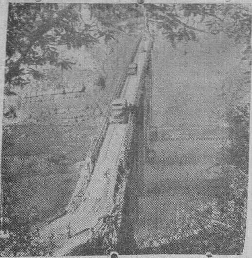
Un puente "Bailey", construido por ingenieros británicos en el frente italiano; para el paso de grandes columnas motorizadas, levantado en pocas horas
