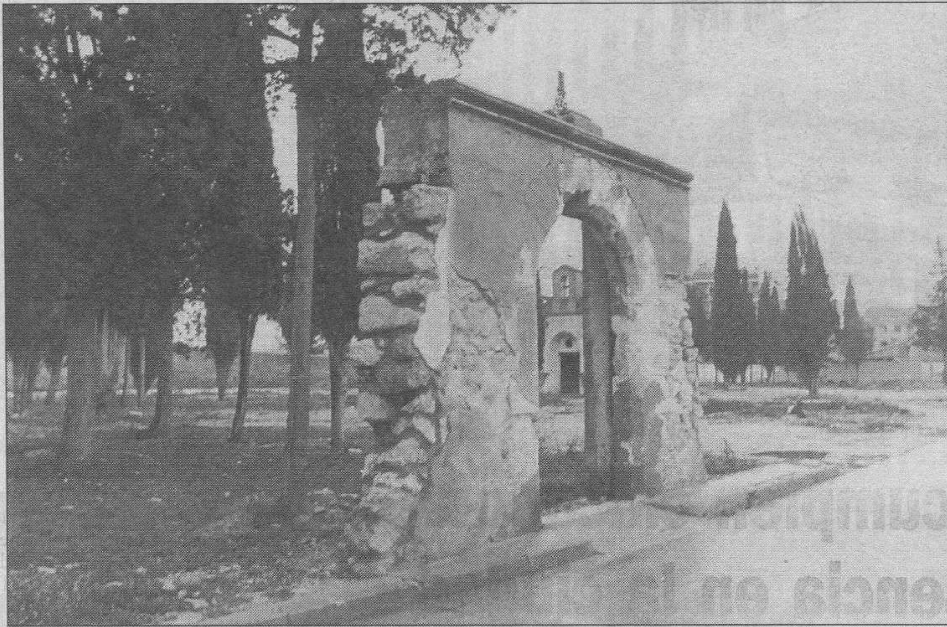
FLORENTINO LARA El Ayuntamiento acordó permutar el camposanto por otro solar en el Polígono Residencial.
