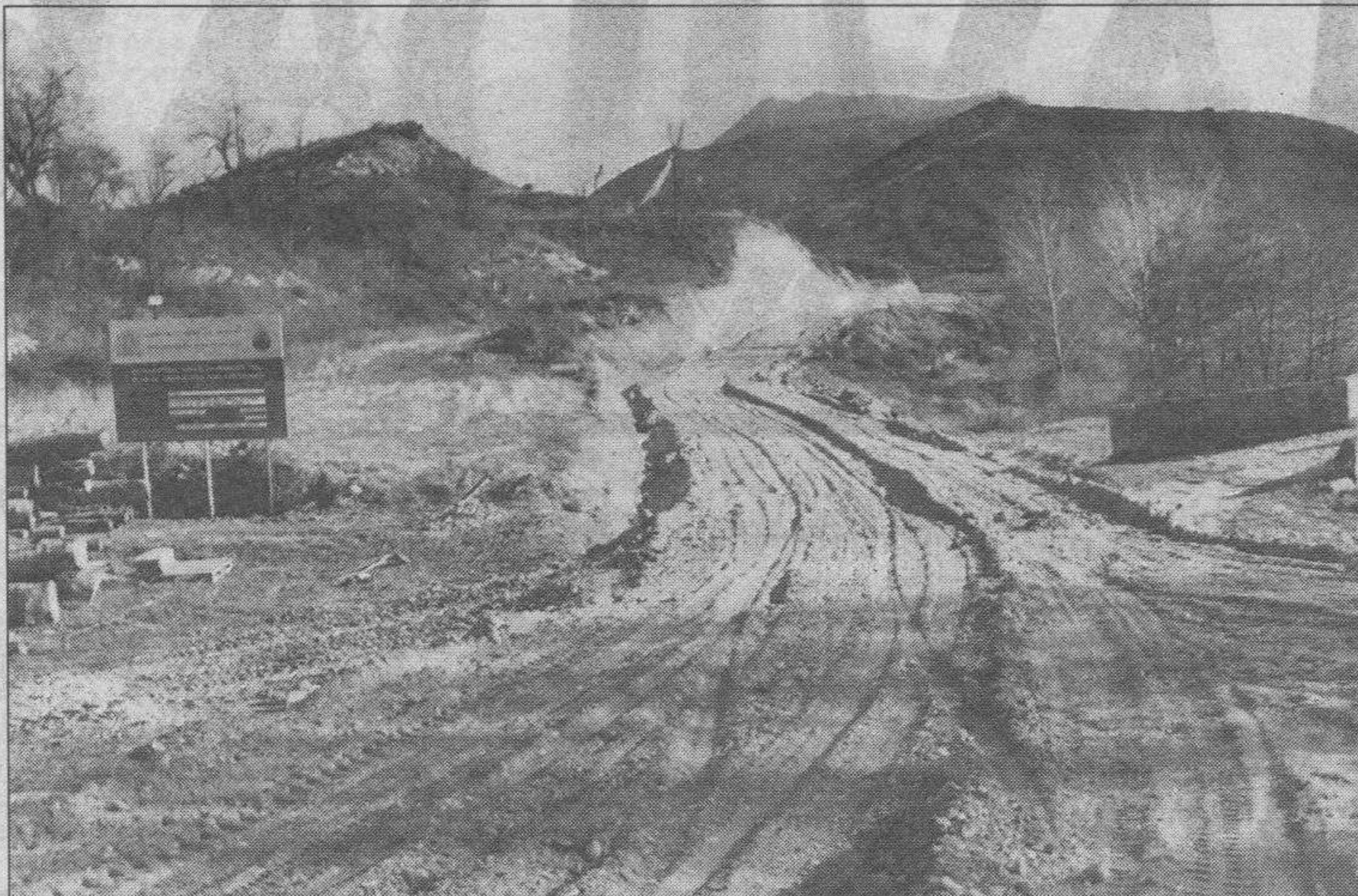
La mejora de este camino era una de las necesidades prioritarias de Frías y Montejo.
