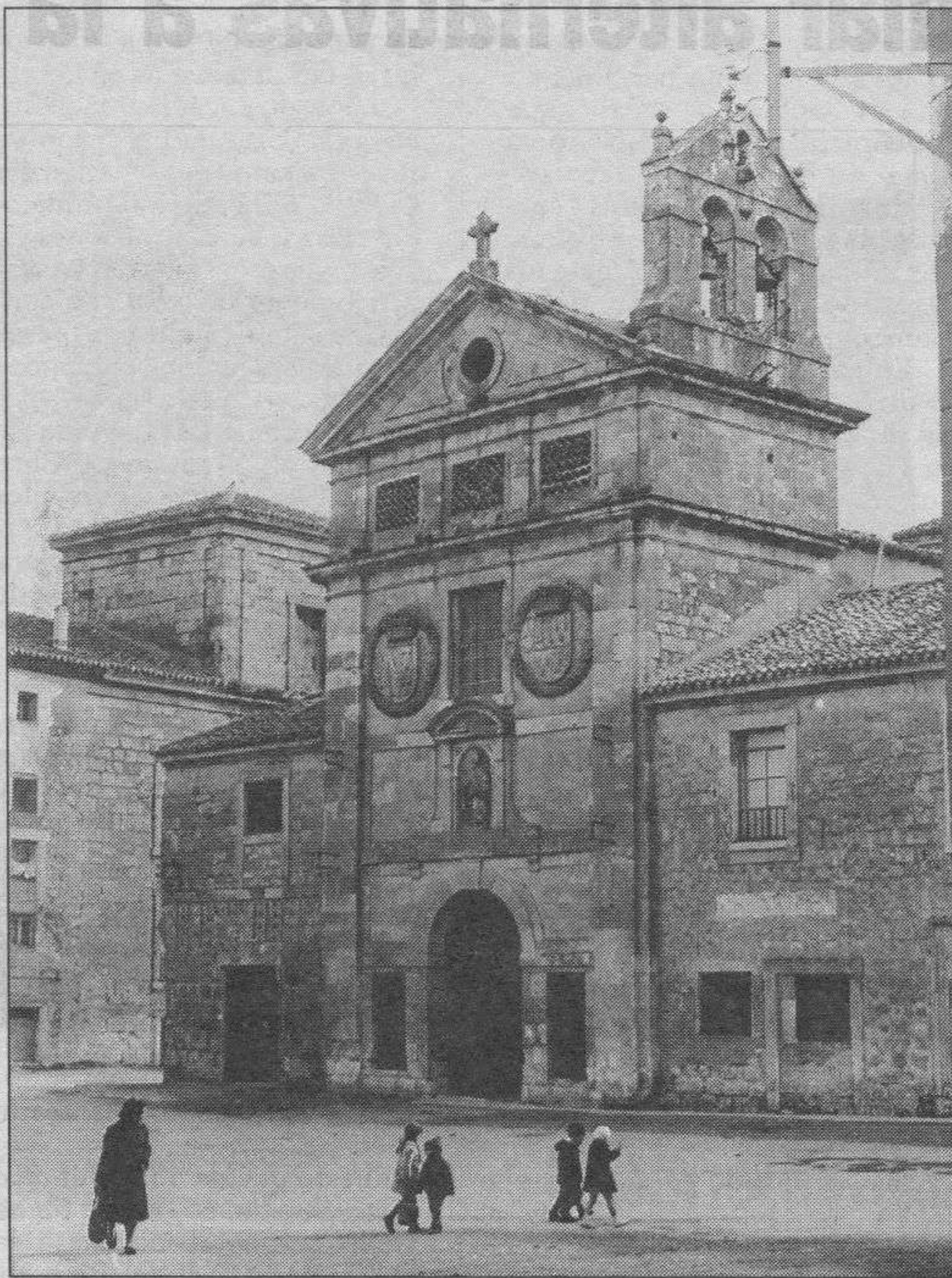
Las obras en el convento de San Blas comenzarán en breve.
