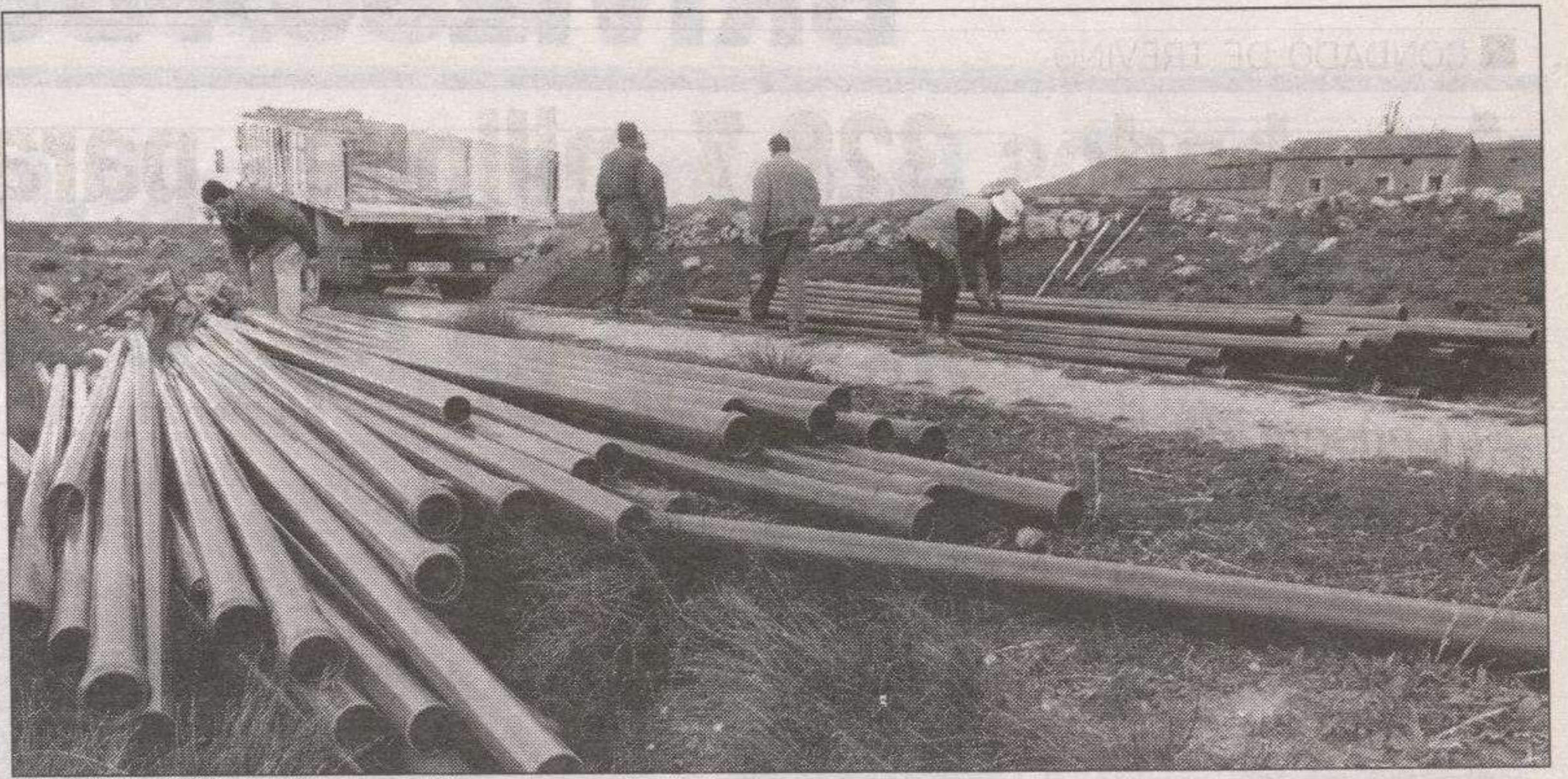
El dinero se destina a realizar obras de captación y abastecimiento de agua en localidades burgalesas. DB
