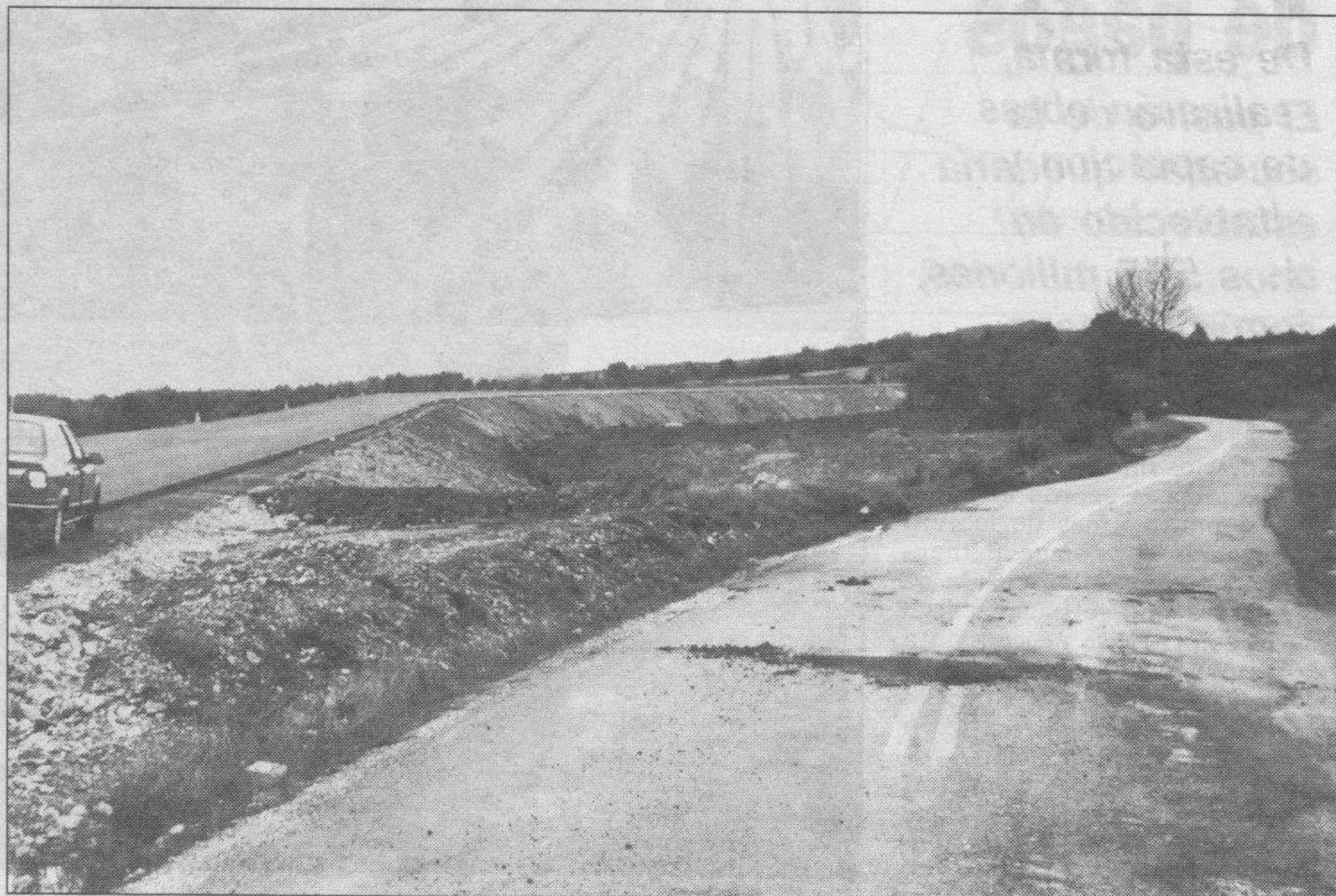
Las obras entre Obécuri y Treviño tendrán continuidad con la nueva inversión aprobada. CHELIS
