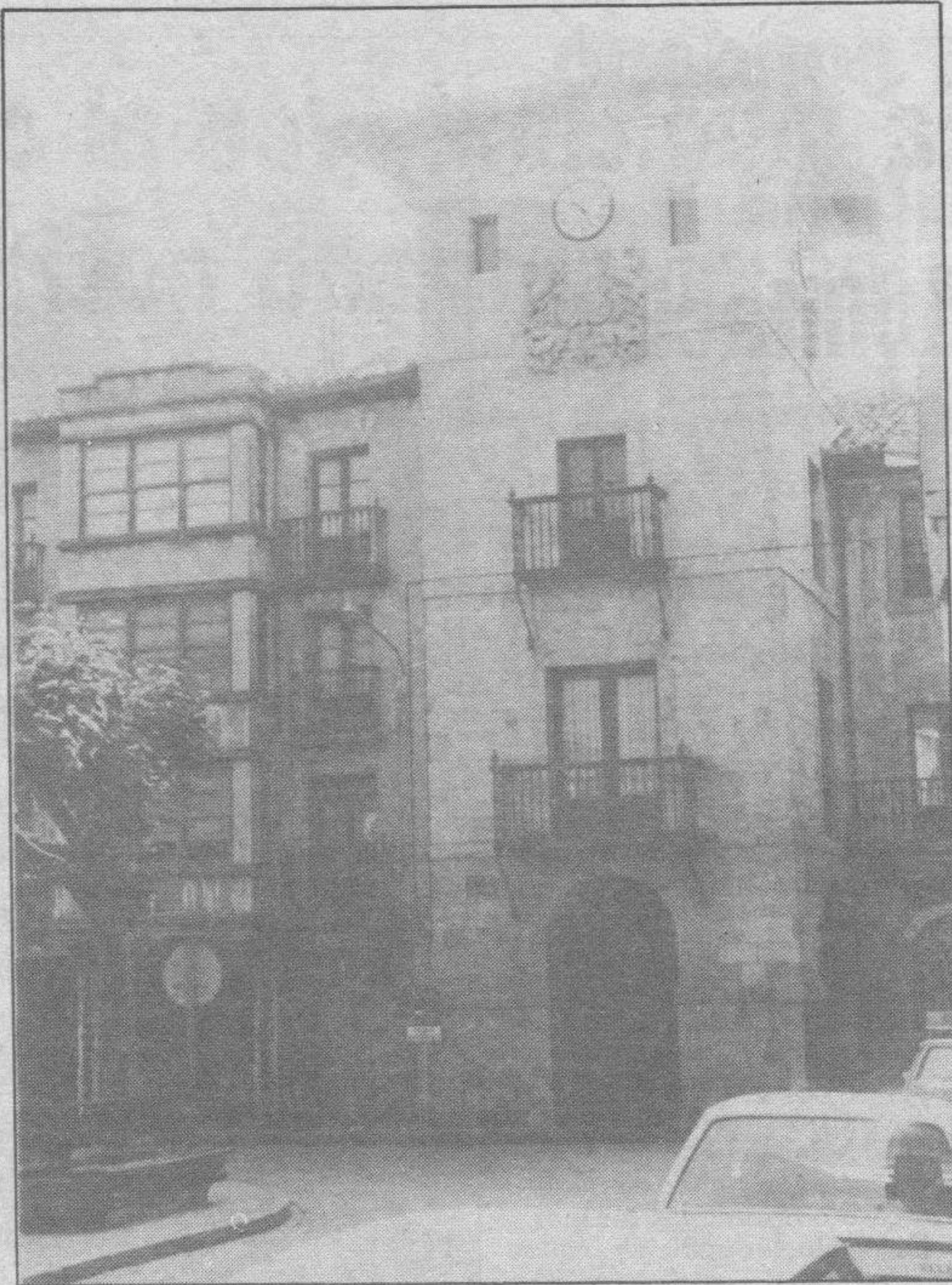
La rehabilitación de la Casa Consistorial, uno de los proyectos.
