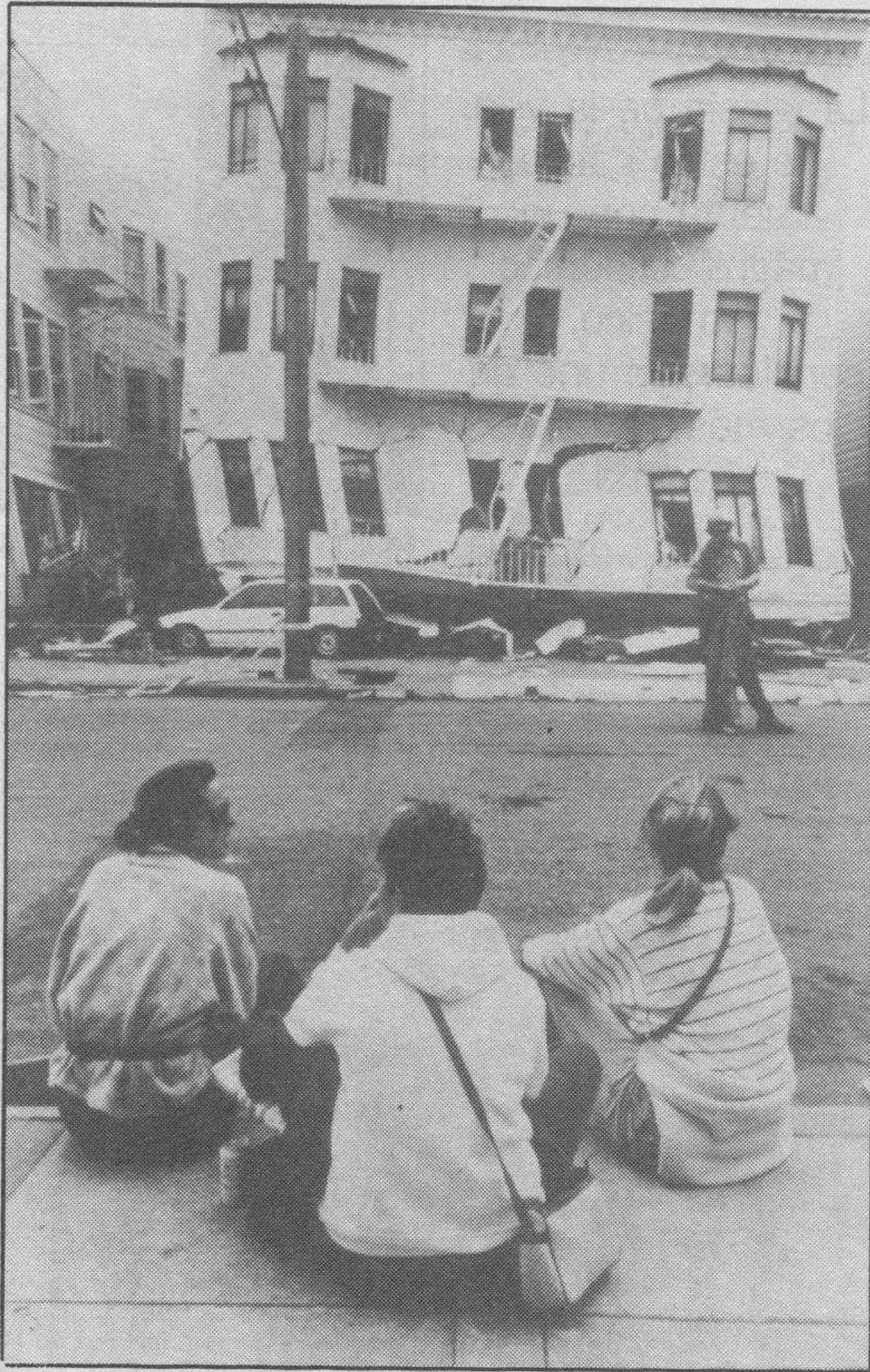
Estado de un edificio de San Francisco, tras un reciente terremoto.
