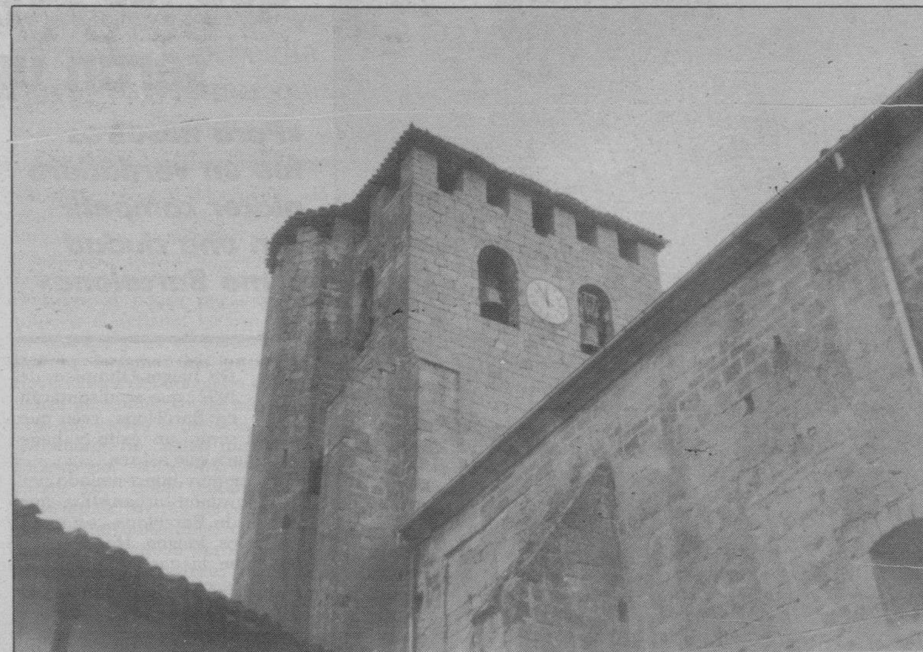
El torreón de la iglesia fue construido por D. Tello, hijo bastardo de Pedro I.
